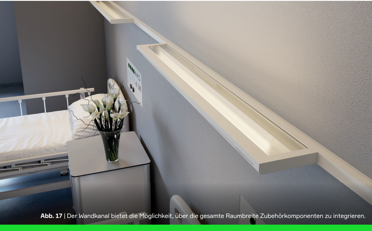
Abb. 16 | Installation mit durchgehendem Wandkanal.
